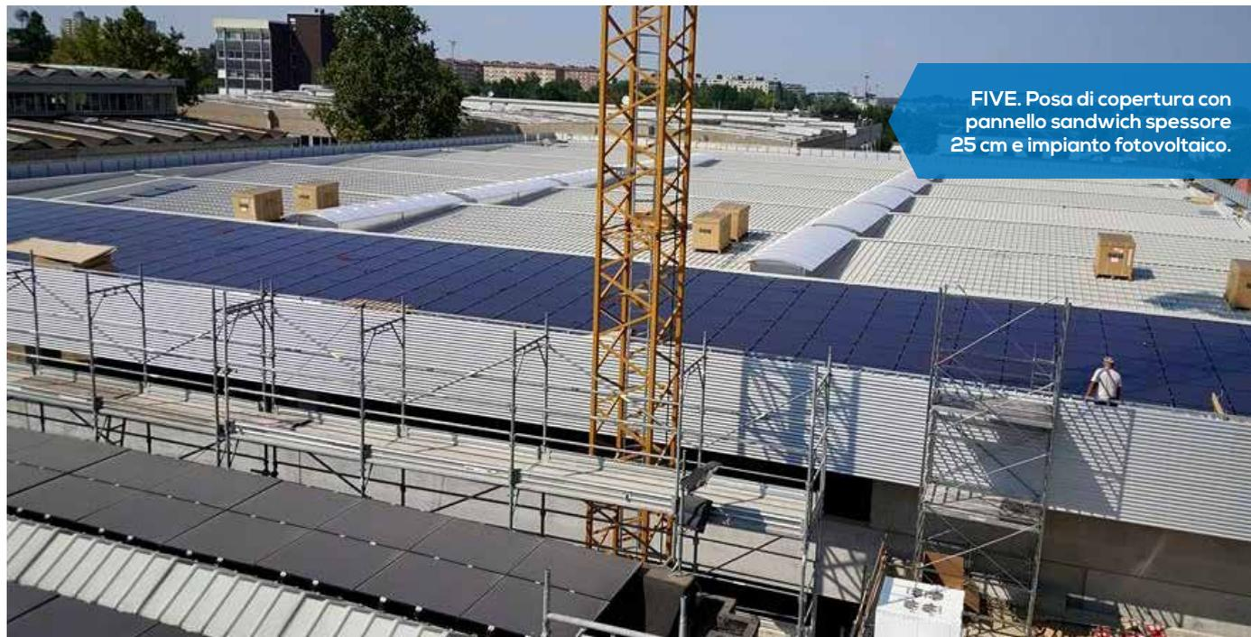
FIVE. Posa di copertura con pannello sandwich spessore 25 cm e impianto fotovoltaico.
