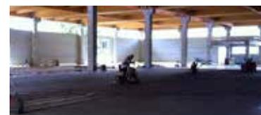
FIVE. Pavimento industriale dello spessore di 25 cm sopra un pannello xps, spessore 12 cm.
